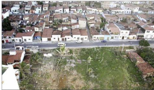
Antes: cenário na rua Guanabara antes do deslizamento de terra, ocorrido entre sexta e sábado
