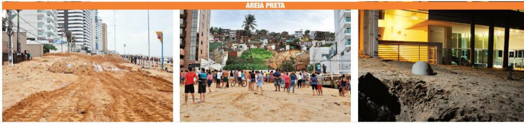
Deslizamento de terra na encosta da Rua Guanabara, em Mãe Luiza, obstruiu a Avenida Silvío Pedroza, na praia de Areia Preta, declarada agora pela Prefeitura de Natal como área "non aedificandi"
