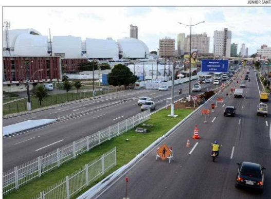
Próximo à Arena, canteiro central da BR-101 ganhou grades de proteção e serviços de jardinagem
