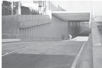
► Túnel da Avenida Capitão Mor-Gouveia sob a Avenida Prudente de Moraes
