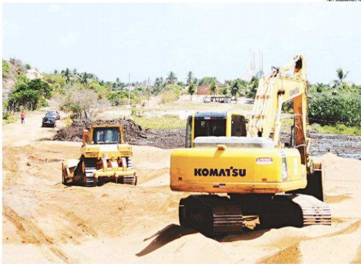
► Obras do Pro-Transporte na Avenida Moema Tinoco, Zona Norte: em execução
