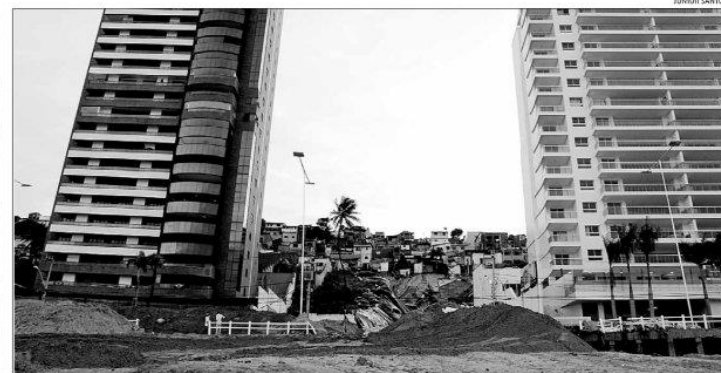
Além do "Infinity" e "Aldebaran", atingidos diretamente pelo deslizamento, outras 13 edificações de Areia Preta devem ser vistoriadas
