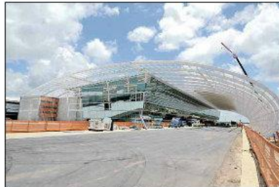
Área externa do terminal: 94% da obra do aeroporto concluída
