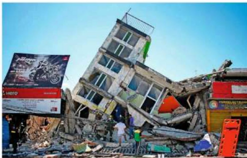
Equipes de resgate e moradores buscam sobreviventes em prédio que desabou em Dosquebradas, na Colômbia. Juan David Duguet/Reuters
