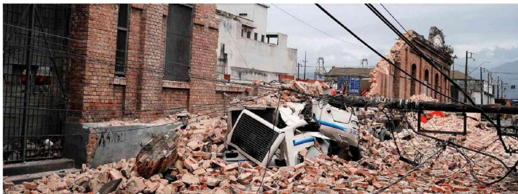
Muro de imóvel derrubado pela ventania em Santos (SP); cidade registrou uma morte e rajadas de até 111,8 km/h, segundo a prefeitura. Nair Bueno/Diário do Litoral
