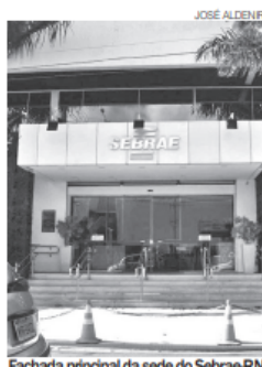
Fachada principal da sede do Sebrae-RN
