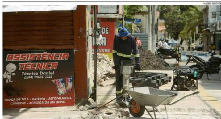
CENTRO A demora na conclusão das obras de revitalização da Rua João Pessoa, na Cidade Alta, tem prejudicado o comércio do bairro. Lojistas relatam queda no movimento e prejuízos nas vendas, além da falta de informações sobre o prazo para finalização dos serviços. » PÁGINA 9 »
