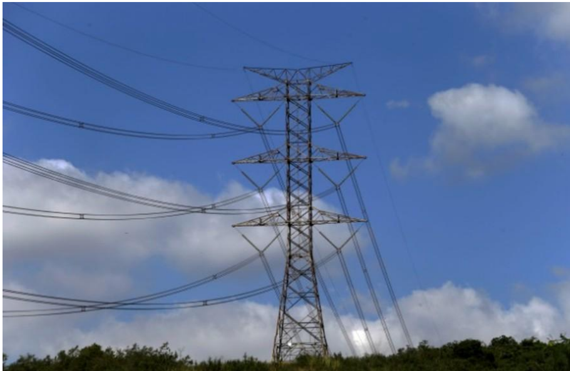
Torre de energia elétrica — Foto: Domingos Peixoto/Agência O Globo
