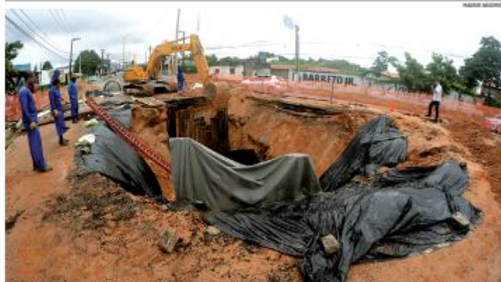
OBRAS Trânsito na Avenida Doutor João Medeiros Filho, próximo ao viaduto do Igarapé, na zona Norte de Natal, passa por alterações temporárias devido a uma obra emergencial de drenagem. Segundo a STN, os serviços concluídos pela Sinfra devem ser concluídos em até 10 dias. » PÁGINA 3
