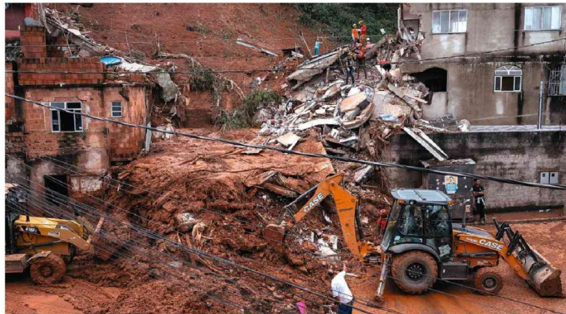
Bombeiros trabalham em área atingida por deslizamento no Parque Jardim Burnier, em Juiz de Fora (MG) Eduardo Anizelli/Folhapress
