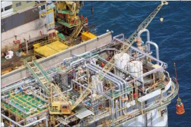
Queda na produção está relacionada ao esgotamento natural dos campos offshore
