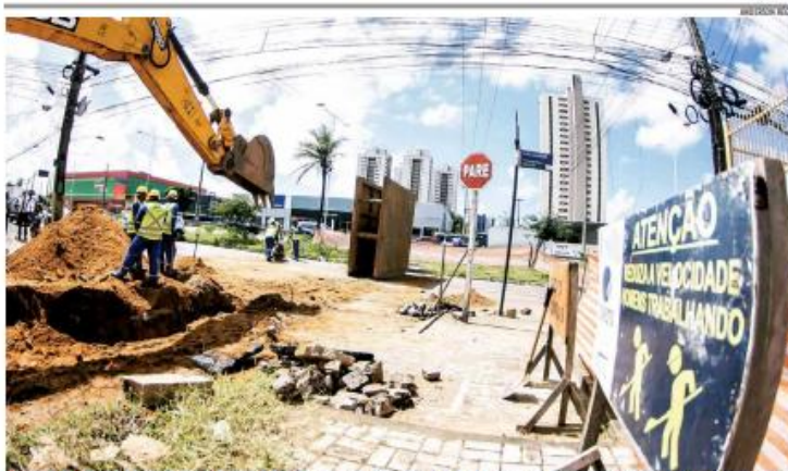
«BLOQUEIO» Um trecho de 80 metros da marginal da BR-301, após a Avenida da Integração, no sentido Parnamirim, foi interditado nesta segunda (4) para obras da Caern. A interdição atual deve durar uma semana, quando novo trecho será bloqueado. Os serviços devem durar 60 dias. «PÁGINA 8»
