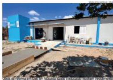
Obras de reforma em UBS em Macaíba; saúde e educação recebem investimentos
