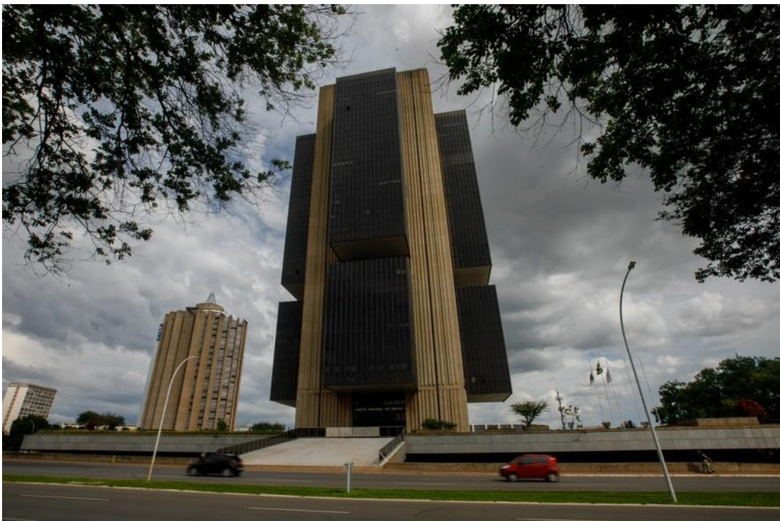
O prédio do Banco Central, em Brasília — Foto: Brenno Carvalho / Agência O Globo
