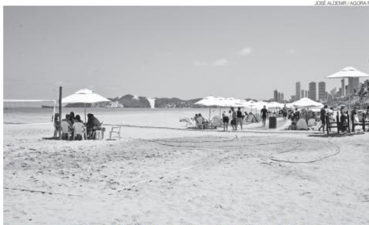
Obra da engorda de Ponta Negra, que deve ser finalizada ainda em janeiro, irá conter os efeitos da maré alta na orla
