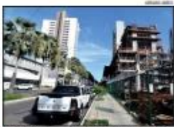
Construção teve expansão em 2024, após Plano Diretor de Natal
