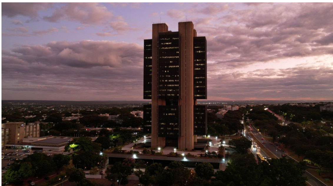
Vista do prédio do Banco Central em Brasília • Adriano Machado/Reuters
