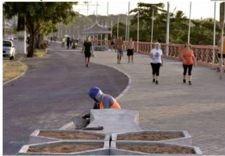
► PEREGRINAÇÃO ► Contemplada com a requalificação de Ribeira, a Avenida do Governo já caiu no gosto dos natalenses como opção de lazer e caminhada. As obras incluem pavimentação, revitalização de canteiros, viabilização de praças e de banhos. ► PÁGINA 9 ►
