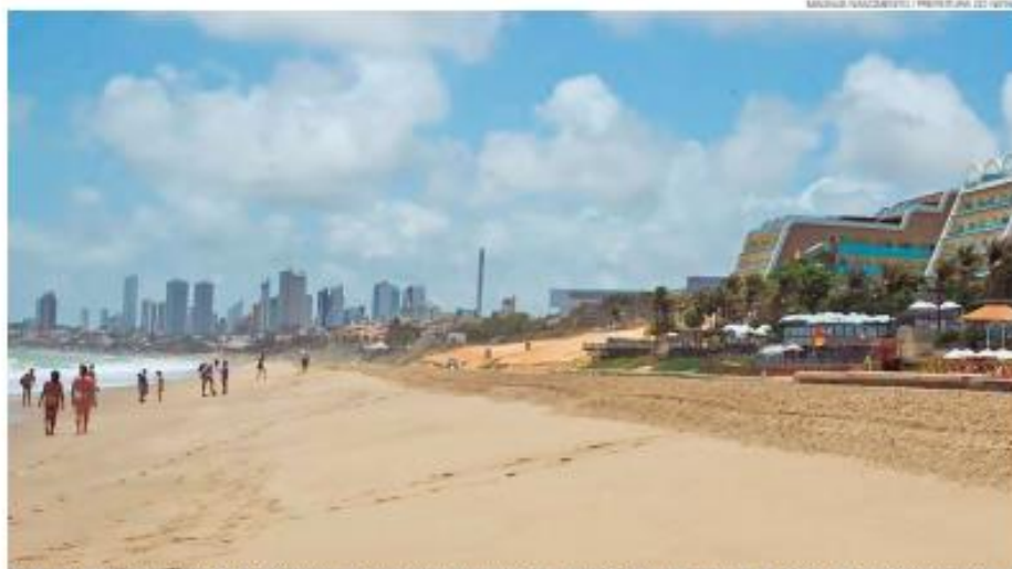
Com engorda, faixa de areia terá até 100 m na maré seca, de acordo com projeto; obra está 25% concluída, faltando a conclusão dos 3 km restantes
