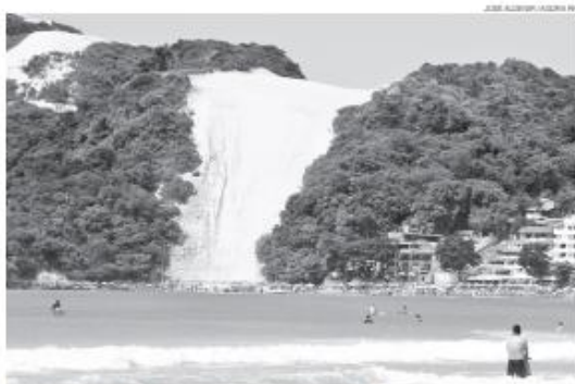
Obra é considerada principal solução técnica para frear erosão no pé do Morro do Caraca, principal cartão-postal do RN
