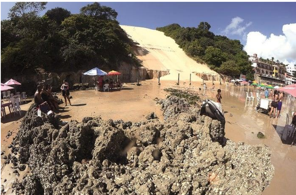
Engorda seria solução para a praia. Erosão costeira tem modificado a estrutura do Morro do Careca | Foto: Magnus Nascimento
