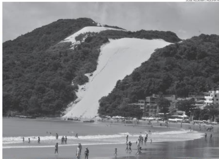
Obra da engorda de Ponta Negra é apontada como principal solução para conter erosão no pé do Morro do Careca
