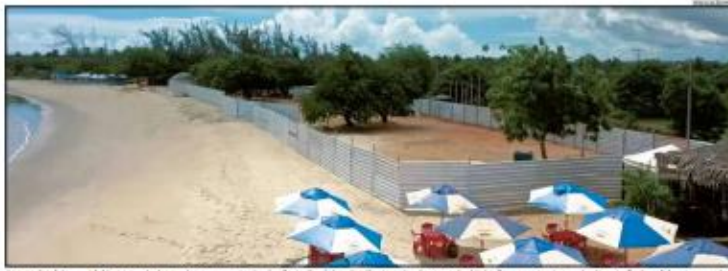
Operários e de uma réplica refeita dos serviços para que a urbanização em Tourinhos, localizada a 8km do centro da cidade, fique pronta a tempo da alta estação de praias temperadas.
