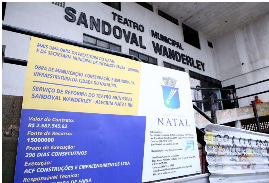
Obras no Teatro Sandoval Wanderley – Foto: Elpídio Júnior / CMN
