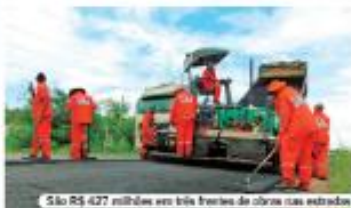
São R$ 427 milhões em três frentes de obras nas estradas
