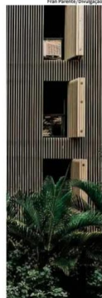
Fachada do Pulso muda quando hóspedes abrem ou fecham janelas dos quartos
