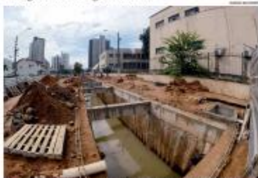
« NOVA REALIDADE » • Obras de regularização no sistema de drenagem do Largo do Silveira, em Petrópolis, estão avançadas. Prefeitura espera concluir projeto em segundo semestre. « PÁGINA 4 »
