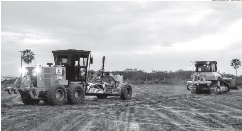
Máquinas já trabalham na construção da nova via, que é comemorada pelo setor produtivo de Mossoró e região; obra é parceria da prefeitura com União
