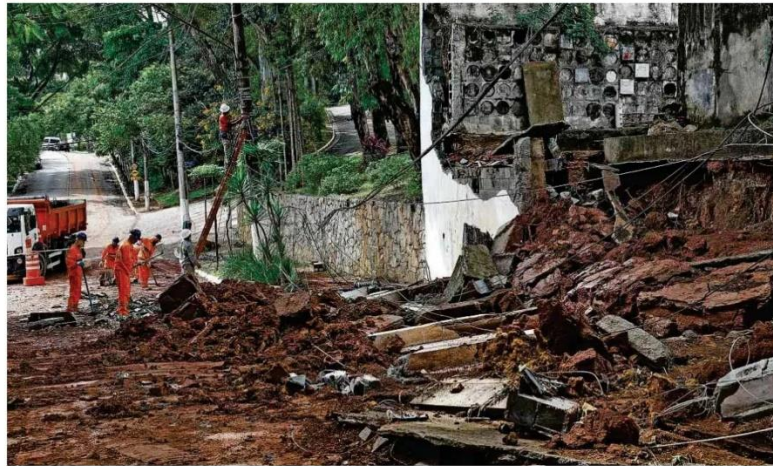
CHUVA DERRUBA MURO DE CEMITÉRIO NO PACAEMBU; CASAL É LEVADO POR CÓRREGO NA GRANDE SP Funcionários fazem limpeza nos fundos do Araçá, na zona oeste da capital paulista; em Suzano, homem morreu e mulher está desaparecida Cotidiano B1
