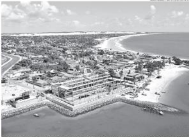
Vista aérea da obra de construção do Complexo Jurídico da Redinha: um dos investimentos da Prefeitura de Natal
