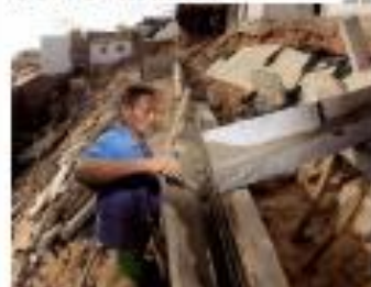
► RECONSTRUÇÃO - O estado que desabou e destruiu 10 casas no bairro de Medeiros começou a ser reconstruído pela Prefeitura e deve ficar pronto até fevereiro de 2025. ► PÁGINA 17
