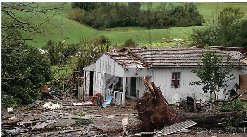
Casa é parcialmente destruída após fortes ventos em Nova Candelária, no noroeste do Rio Grande do Sul; estado registrou uma morte Divulgação/Defesa Civil do RS
