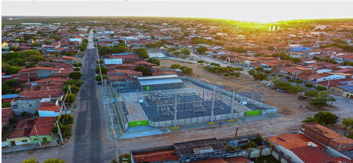
Nova subestação elétrica, no bairro Belo Horizonte, em Mossoró
