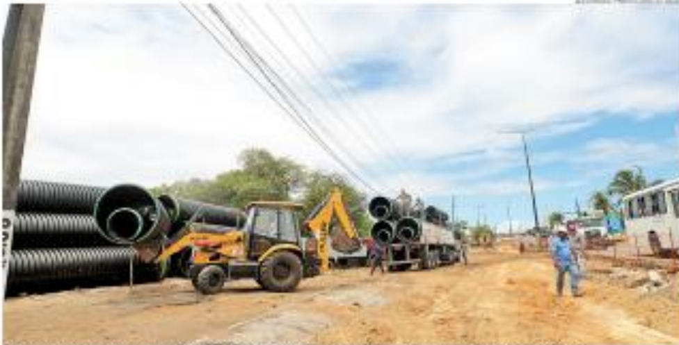
Fase de retirada da camada de asfalto e da base da via foi iniciada e cerca de 400m, na pista da esquerda sentido Centro-Zona Norte
