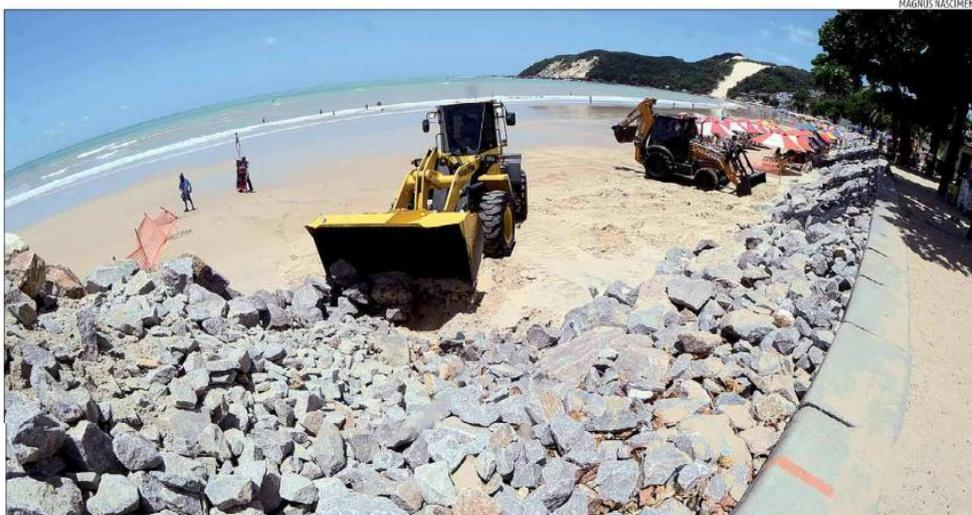
Obras em Ponta Negra são esperadas há anos para diminuir a erosão na praia. Além da engorda da faixa de areia, será ampliado o enrocamento com pedras
