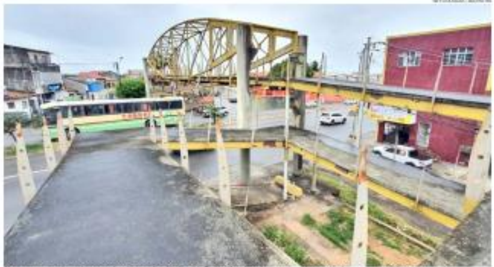
Nesta semana, pedreiros da passarela caíram na Avenida Nazário Rocha. Microempreendedores que estruturam desabam e provocam acidente grave na via
