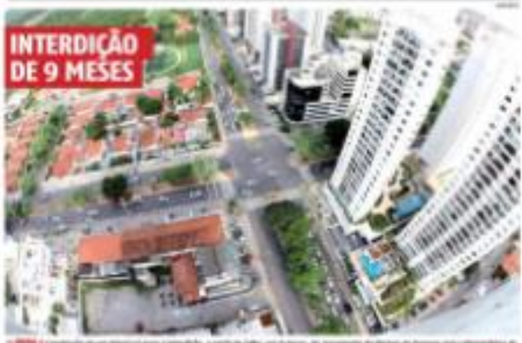
Interdição de 9 meses para obras de infraestrutura em uma das principais ruas da cidade. O trabalho será concluído até o final do ano.
