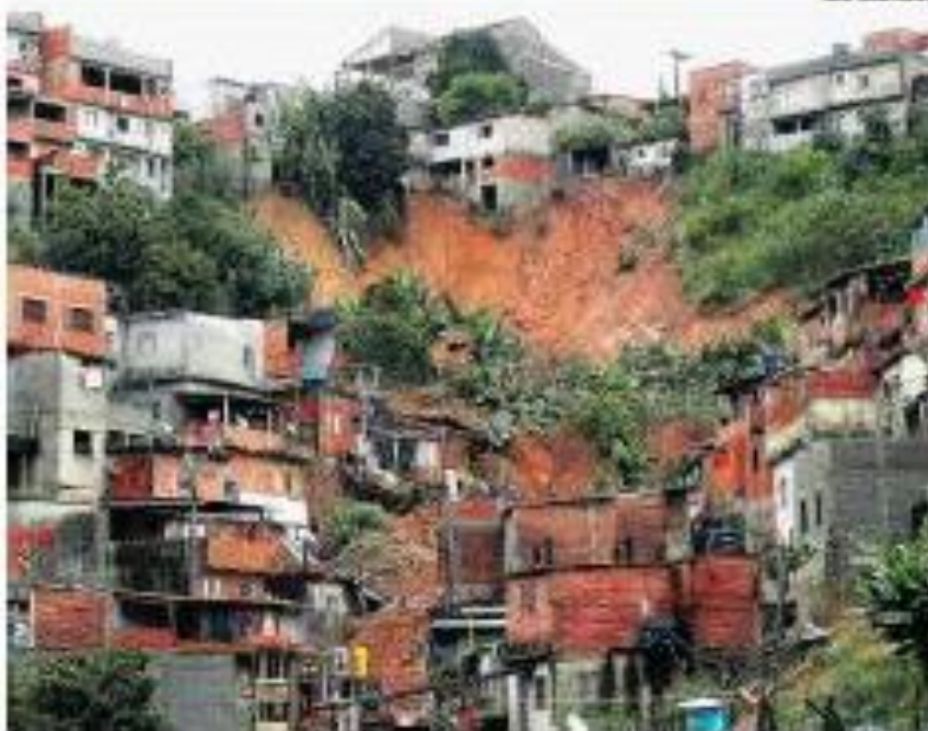
Deslizamento de terra sob uma casa e outras casas destruídas no bairro Parque Paulista, em Franco da Rocha, após chuvas fortes
