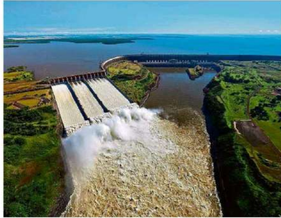
Usina de Itaipu. Como não pode ser privatizada, hidrelétrica permaneceria como estatal. Já subsidiárias como Furnas e Eletronorte seriam vendidas juntas ou separadas
