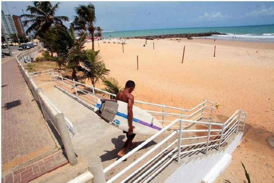
Na praia de Miami, na zona leste da cidade, foi instalada uma rampa junto à escadaria que já havia no local.
