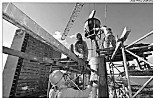
Patamar de atividades da construção está 4,5% menor que o observado no último trimestre de 2019
