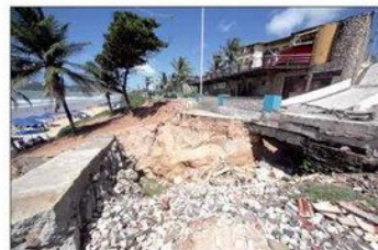
Trecho atingido por erosão começa a ser recuperado na segunda
