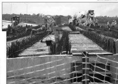
Viaduto de conexão ao acesso norte ficará pronto em setembro
