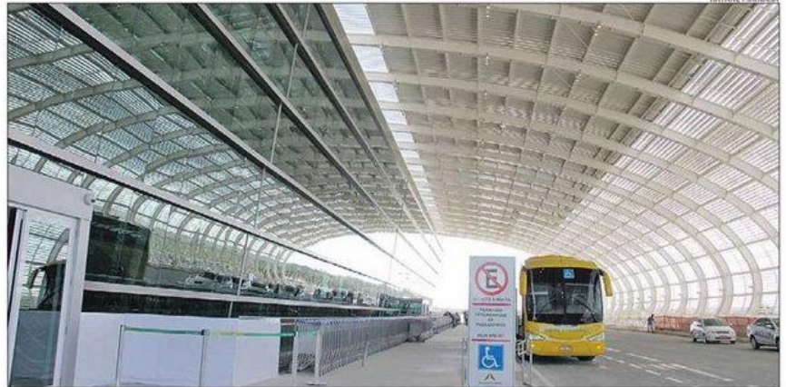
Aeroporto Governador Aluizio Alves, em São Gonçalo do Amarante (RN): Engevix opera aeroporto em conjunto com grupo argentino
