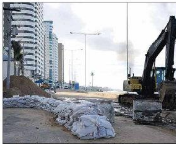
Prefeitura ainda faz limpeza na avenida Sílvio Pedroza
