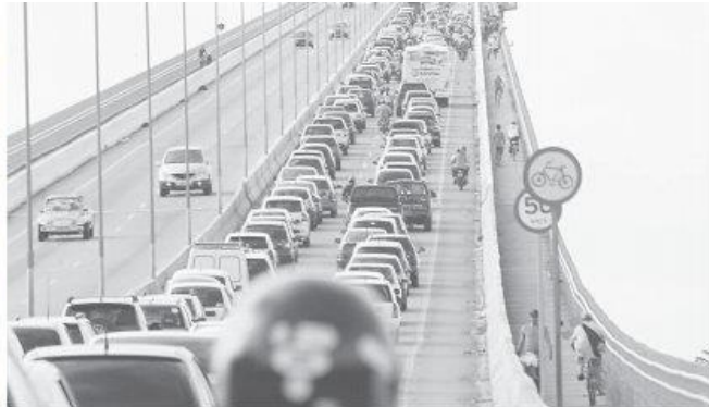
Ponte Newton Navarro, inaugurada em 2007: fluxo de veículos é prejudicado por falta de obras complementares
