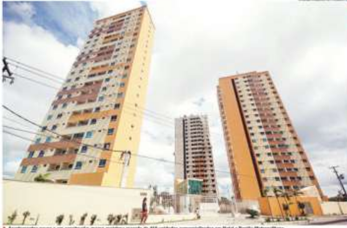
Apartamentos novos em construção; março registra recorde de 430 unidades comercializadas em Natal e Região Metropolitana
