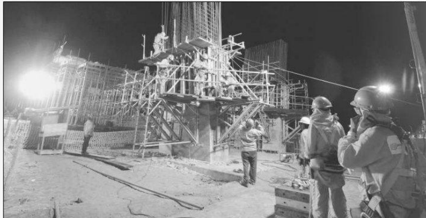
Desde ontem, o regime de trabalho no entorno da Arena passou a ser de 24h e deve durar até o final das obras, previsto para maio
